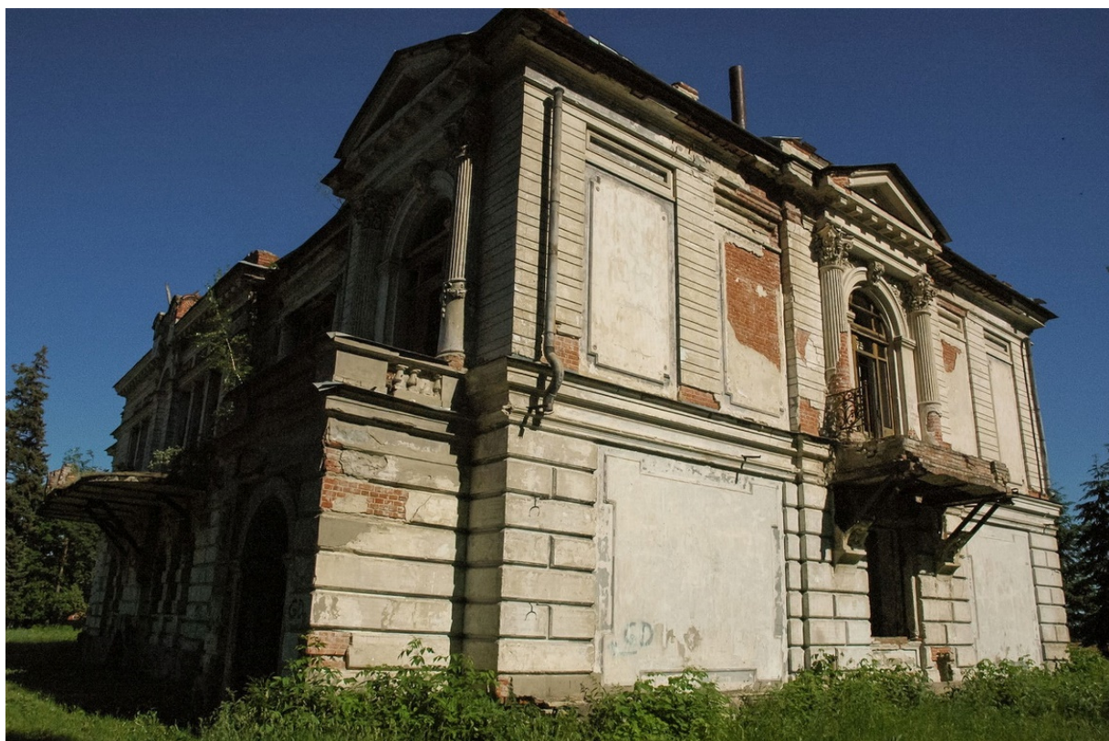
Рис. 1. Дом В. Т. Асеева. Северный и западный фасады до реставрации. Фото М. Зайцевой (2010 г.)
