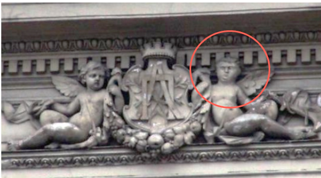
а) реставрация лица ангела на доходном доме Павла Лихачёва на Невском проспекте (г. Санкт-Петербург, 2015 г.) [21];
