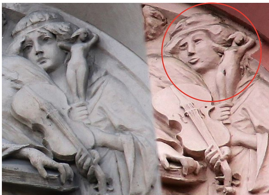
б) реставрация барельефа на «Доме печального ангела», ул. Восстания, 19, (г. Санкт-Петербург, 2015 г.) [21]; слева – как выглядел исходник, справа – отреставрированный элемент
